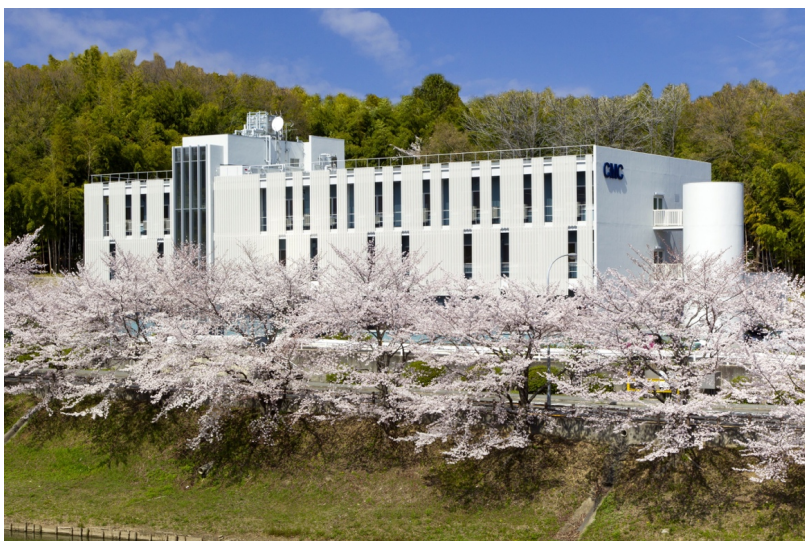
CMC吹田本館
